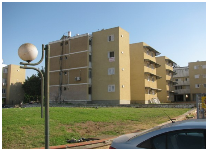
Bij de flatgebouwen van Sderot zijn versterkte kamers aangebouwd met een klein raam, dat met een stalen plaat kan worden afgedekt.
