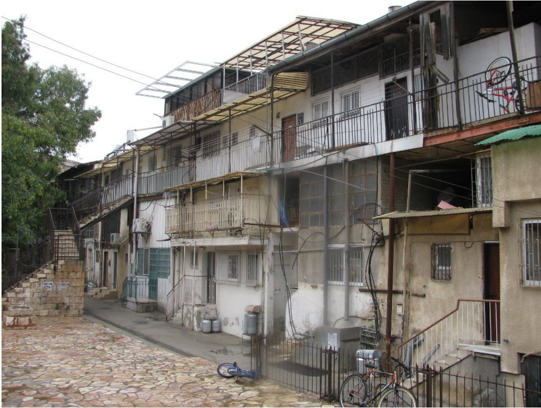
De gasvoorziening in de Jeruzalemse Joodse wijk Mea Shearim is in onze ogen nogal primitief: gasflessen op de binnenplaats en buizen en slangen langs de gevel. (eigen foto)
